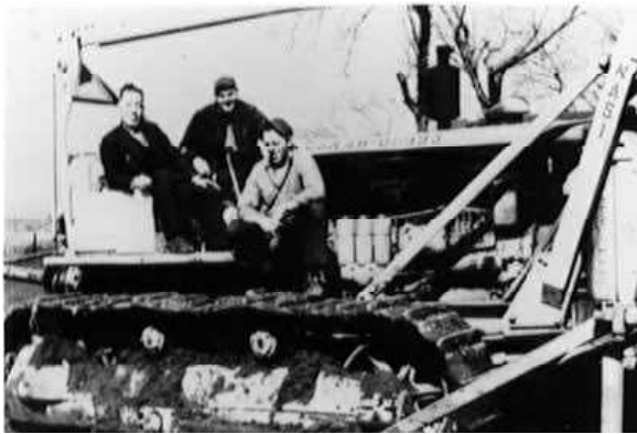
「海老名中学校の校庭工事を行う米軍」
